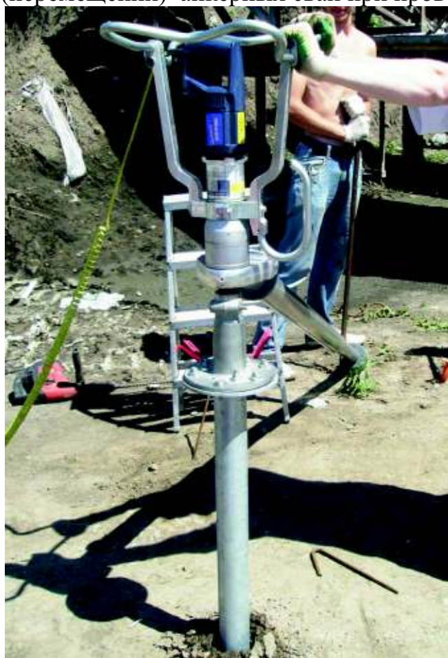
Фото 10- Погружение свай «BAU» в грунт на экспериментальных площадках
