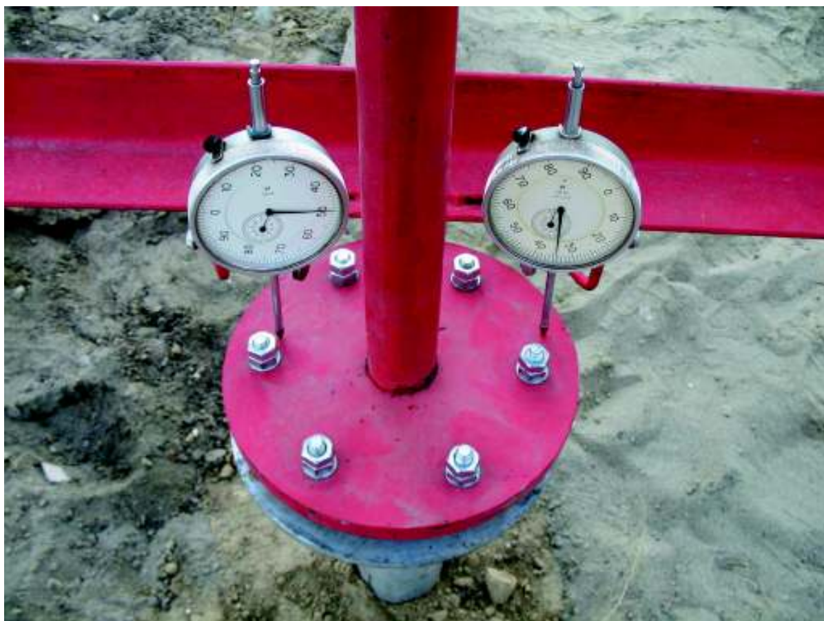
Фото 7- Установка индикаторов часового типа ИЧ-50 при испытании свай на выдергивание
