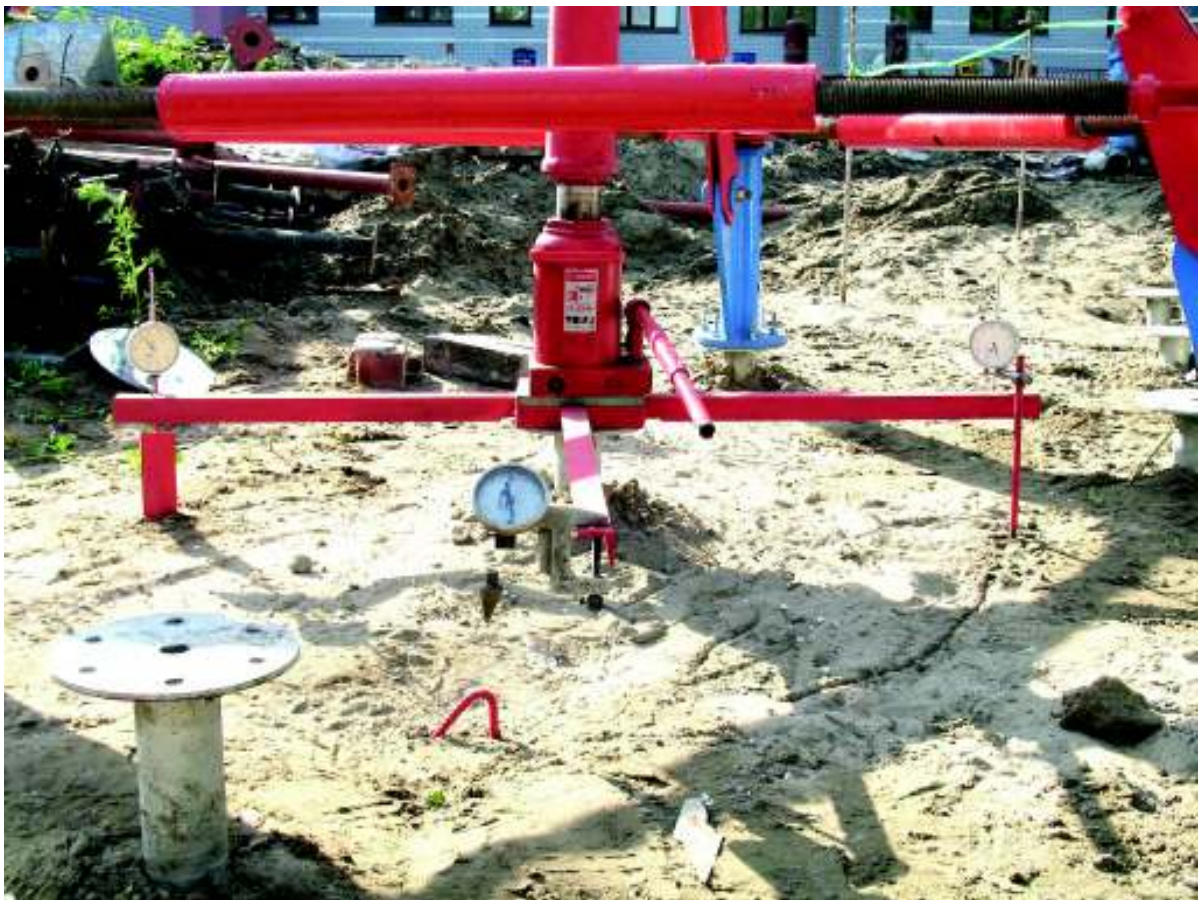
Фото 14 – Испытание свай на вдавливающую нагрузку
