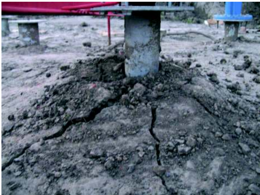
Фото 13 – Испытание свай на выдергивающую нагрузку
