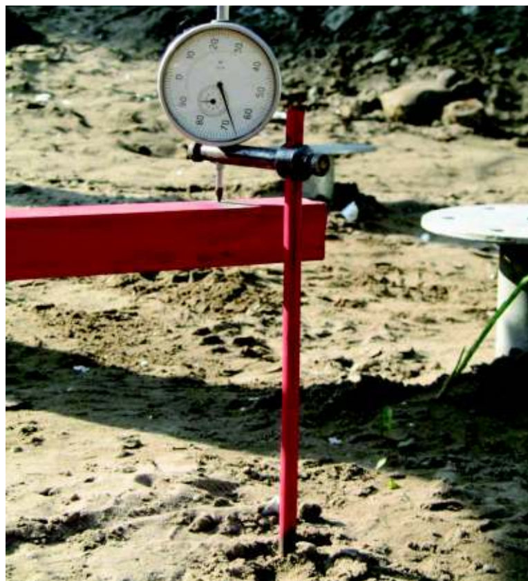
Фото 7- Установка индикаторов часового типа ИЧ-50 при испытании свай на вдавливание
