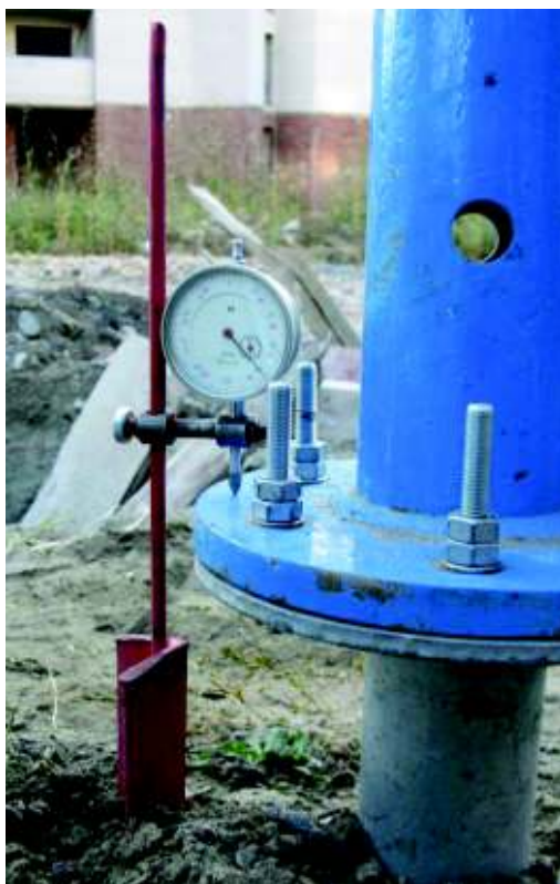
Фото 9- Установка индикаторов часового типа ИЧ-10-2М для контроля деформирования (перемещений) анкерных свай при проведении испытаний
