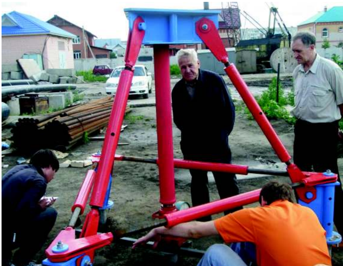
Фото 12 – Испытание свай на вдавливающую нагрузку
